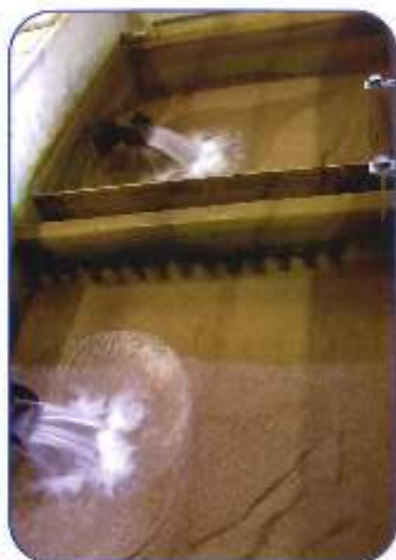
Filtration dans bac à sable
