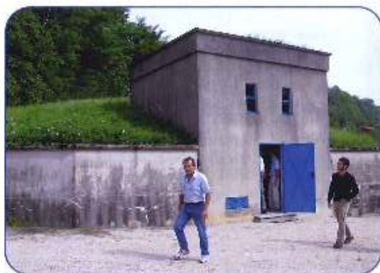
Réservoir tampon de stockage
